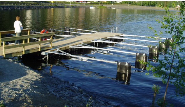
Plastpontongbrygge med fortøyningsbommer
